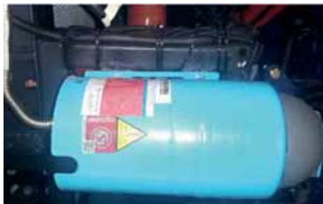
کپسول های اطفاء حریق تیپ ۲
