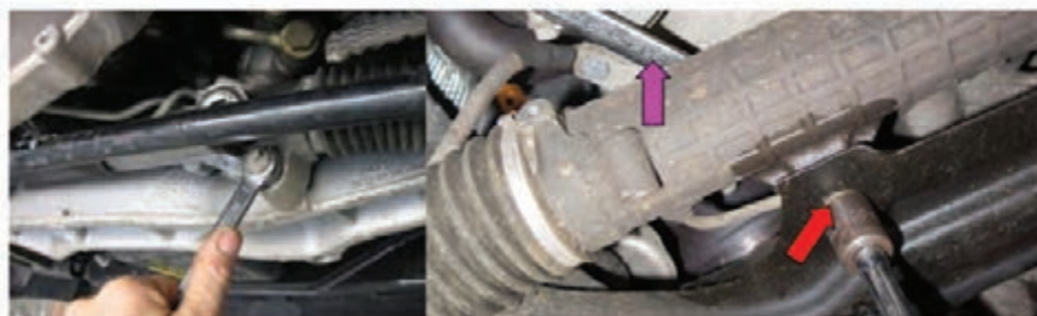
شکل ۲۰ - سفت کردن اتصالات جعبه فرمان
